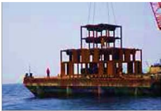
大型的鋼結構投放。
